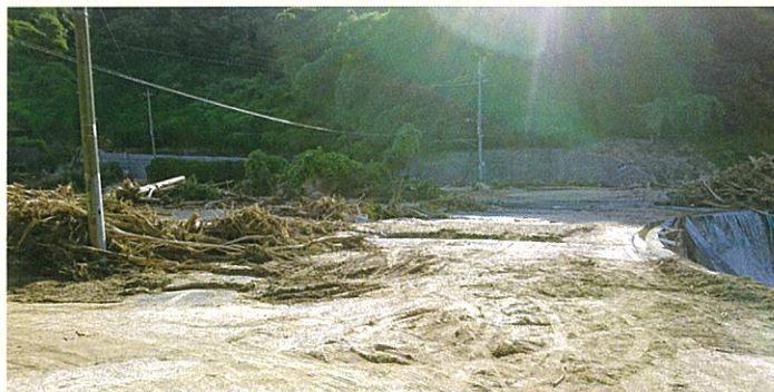
被災したA病院前道路の様子
