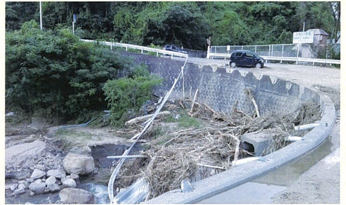
被災したA病院前道路の様子
